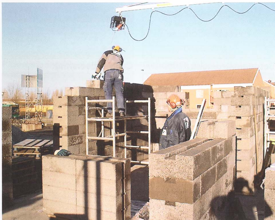
Förskola i Bunkeflostrand, Malmö byggs med Maxit DSM.
