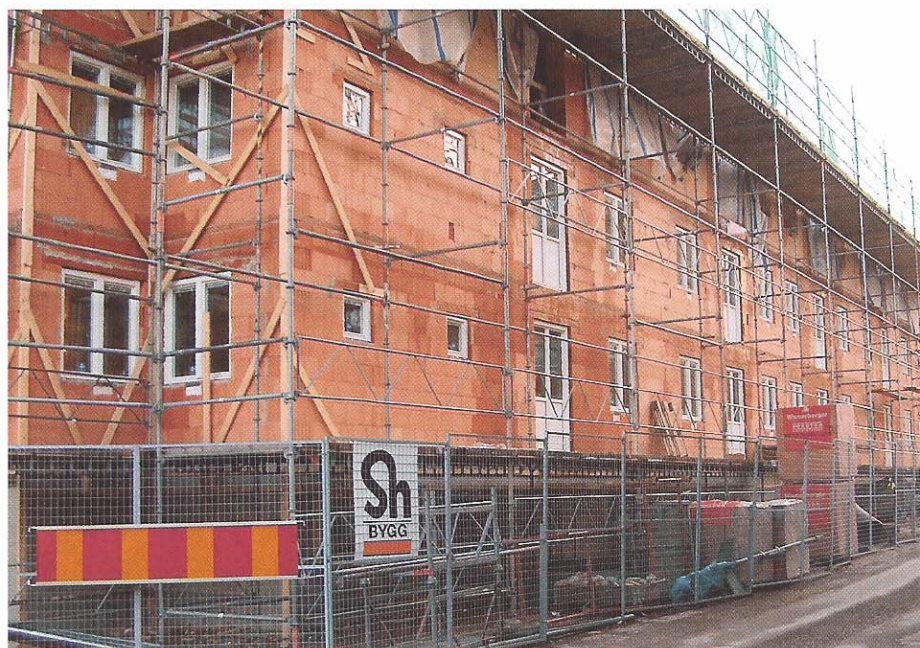
Flerbostadshus kv S:t Johannes, Uppsala byggs med stomme av Porotherm tegelblock.
