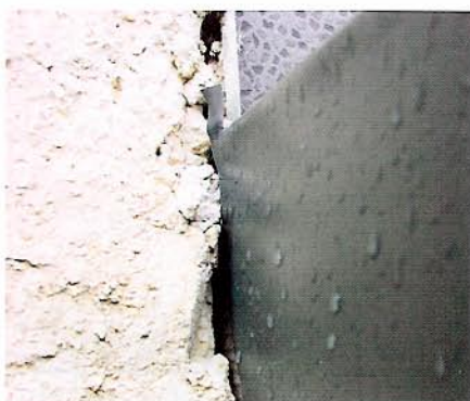
Bild 10. Otätheter vid skärmtaksinfästning.
