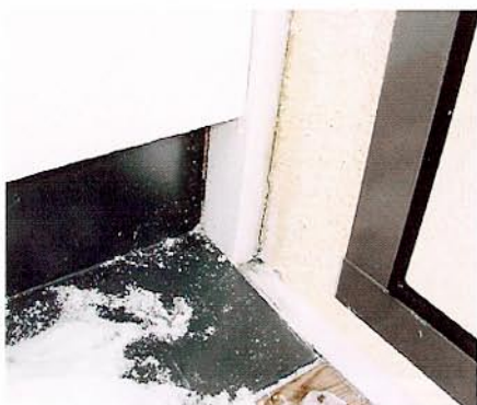
Bild 9: Otätheter vid sidoanslutning till balkong.
